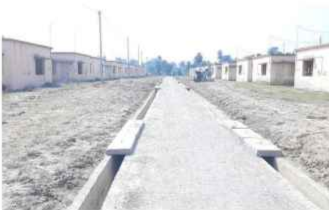
पुनर्वास कॉलोनी, साहिबगंज में सड़क का निर्माण
