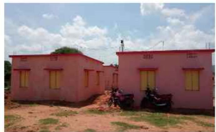
साहिबगंज में पुनर्वास स्थल पर मकानों का निर्माण
